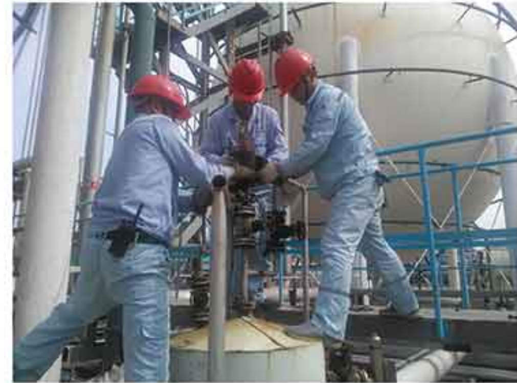
（储运班人员进行检修储罐切水装置）
